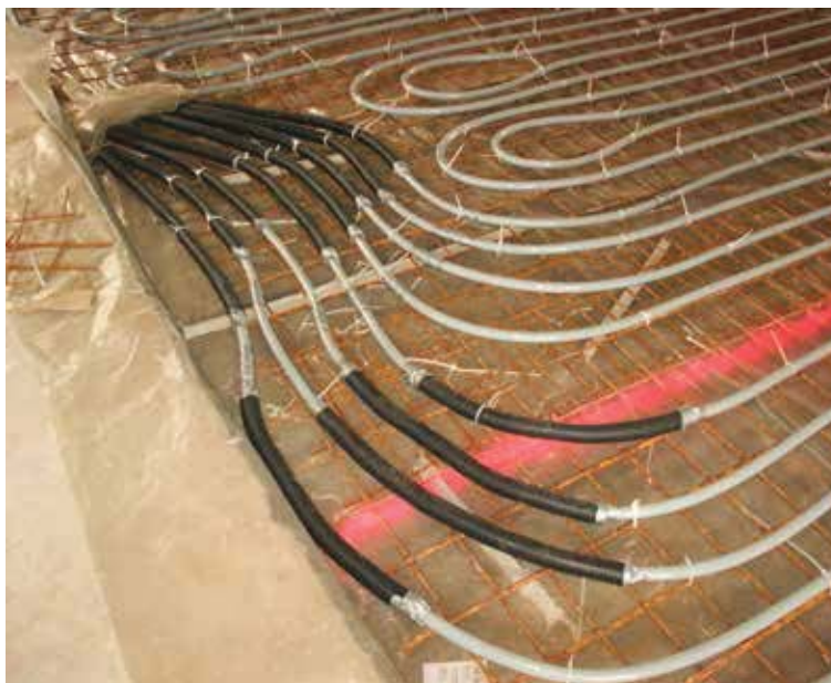
Beispiel für die Ausführung einer Thermischen Bauteilaktivierung im Neubau eines Gewerbeobjektes, wo das verwendete PE-X Heizrohr auf Rohrträgermatten befestigt wurde.
