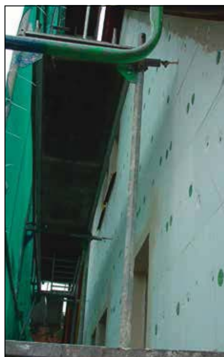
Abb. 4: Befestigung eines Arbeitsgerüsts mit langen Ösenschrauben bei Montage eines WDV-Systems
