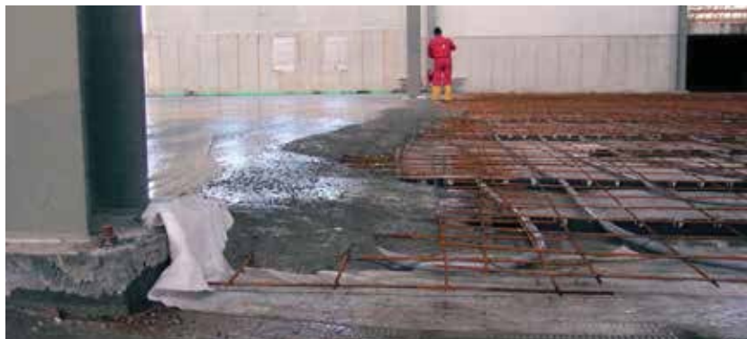
Beispiel für die Ausführung einer Thermischen Bauteilaktivierung im Neubau eines Gewerbeobjektes, wo das verwendete PE-X Heizrohr auf Rohrträgermatten befestigt wurde.
